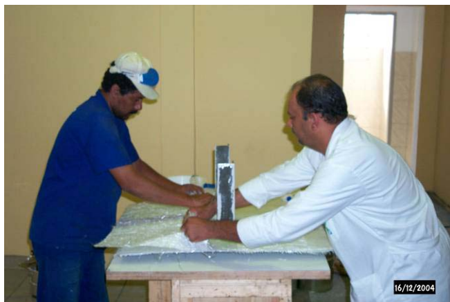
Foto n.º 3 - Aplicação do Reforço Estrutural
